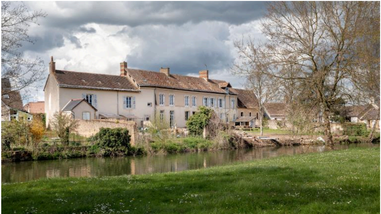
Les bâtiments depuis les bords de l'Huisne.
