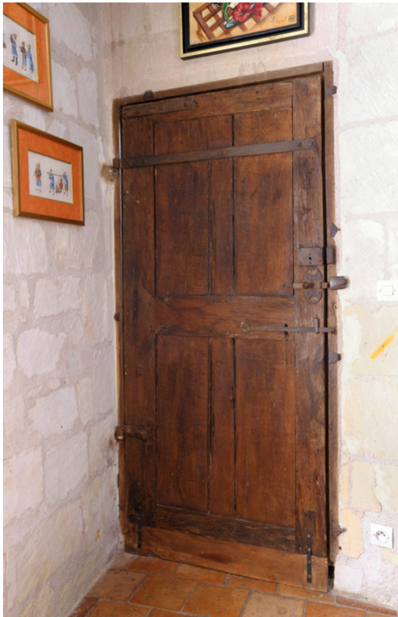
Corps ouest, rez-de-chaussée : porte du XVI e siècle (face intérieure).
