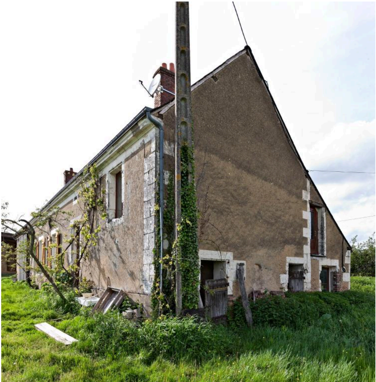
Ferme bloc à terre : vue de volume prise du sud-est.
