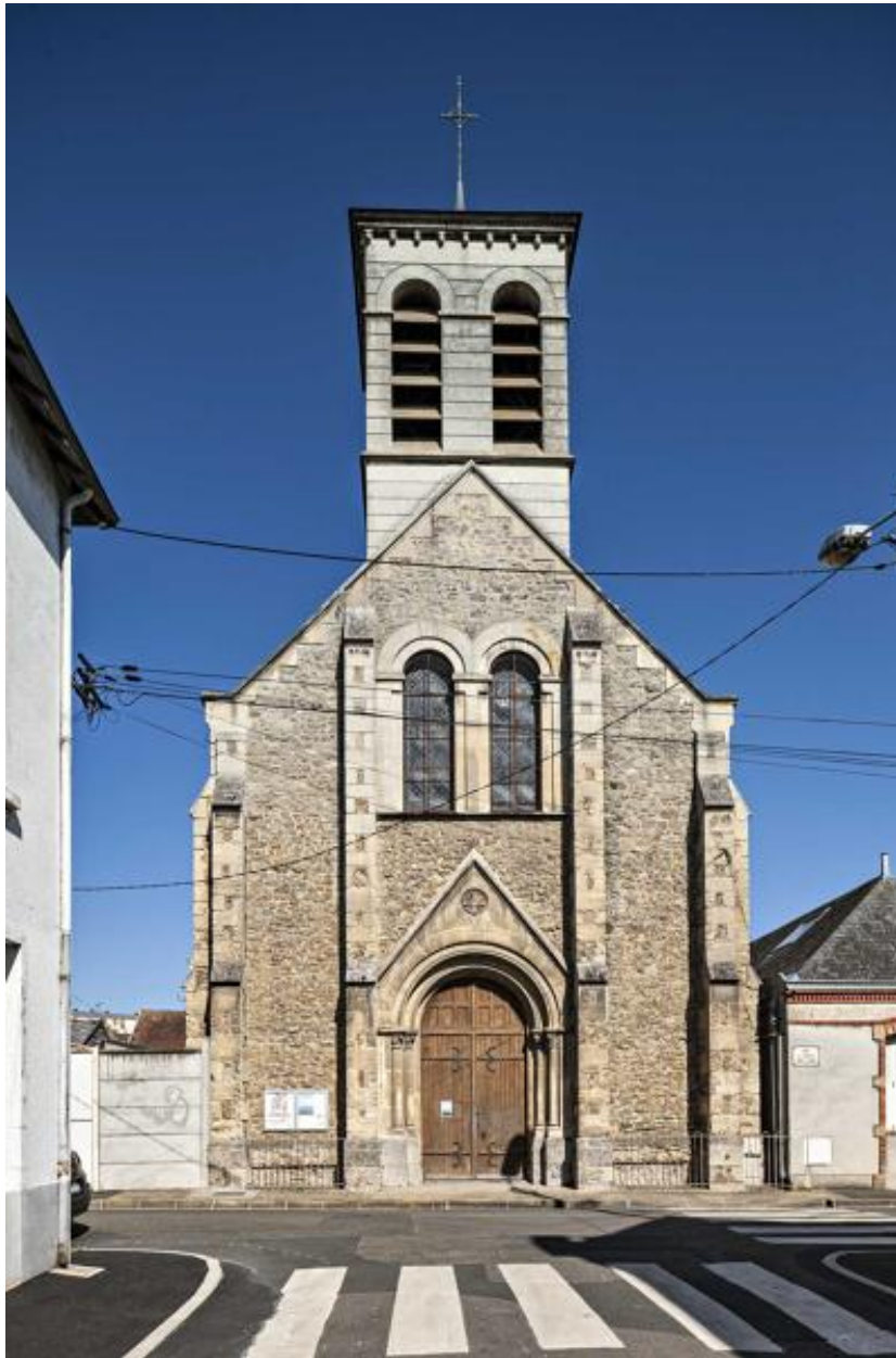
Vue de la façade principale depuis la rue.
