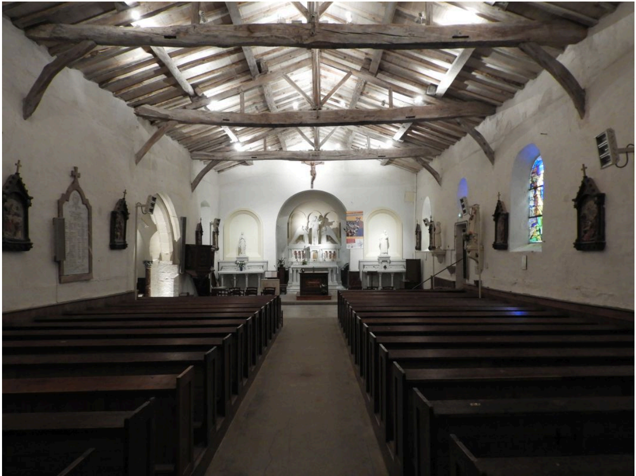
Vue intérieure depuis l'entrée, en direction de l'est.
