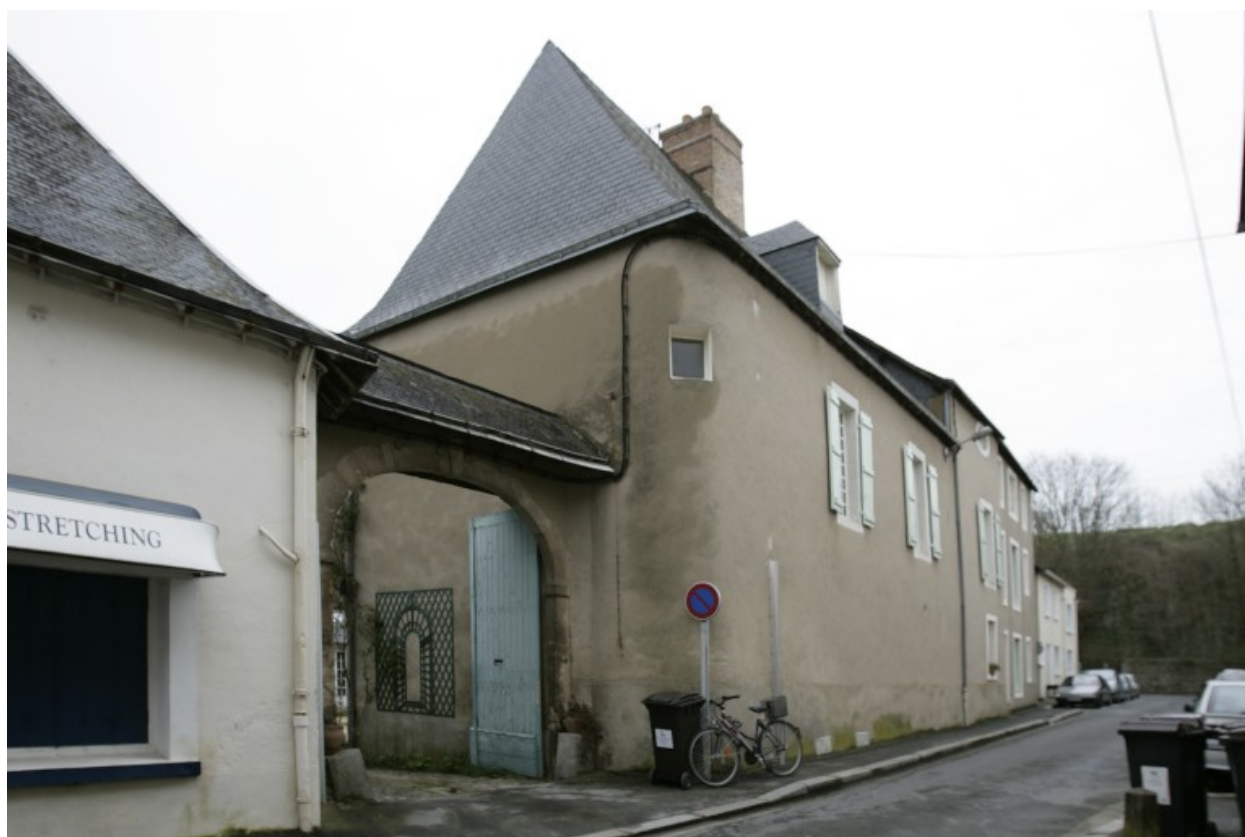
Façade sur rue : vue d'ensemble depuis le sud.
