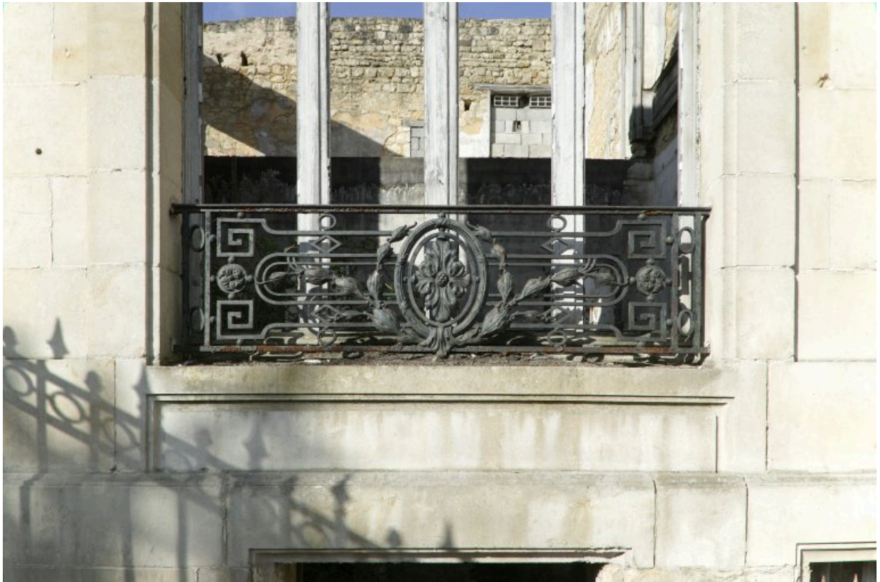
Garde-corps de la fenêtre à droite de l'escalier extérieur.
