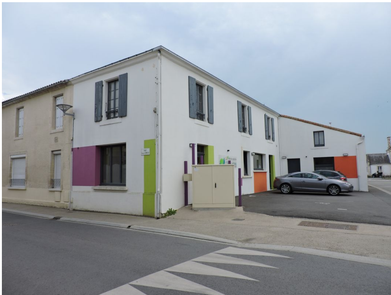
La crèche, ancien bureau de poste, vue depuis le nord.
