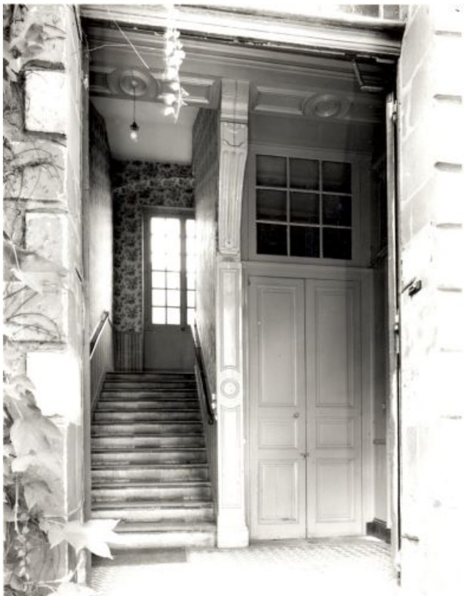
Vestibule et escalier : vue d'ensemble.
