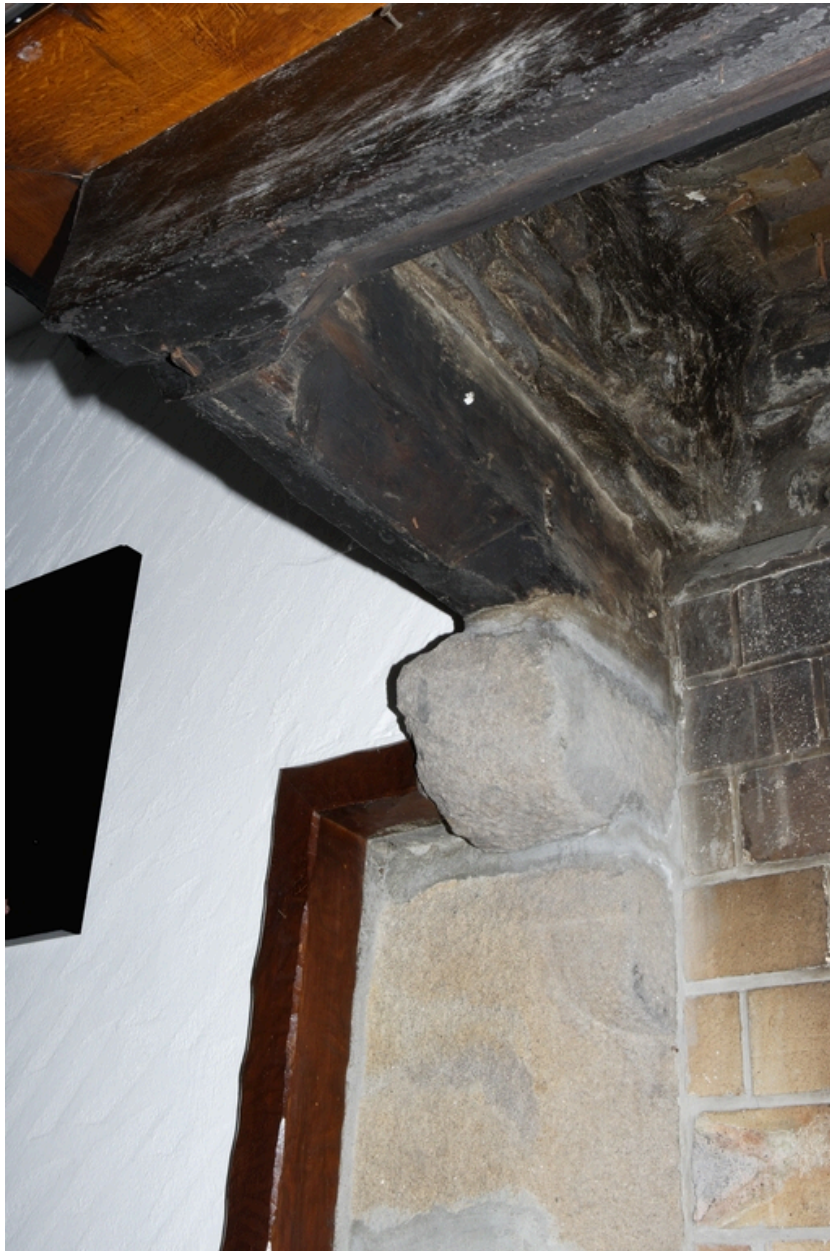
Détail du corbeau de gauche de la cheminée du n° 25.
