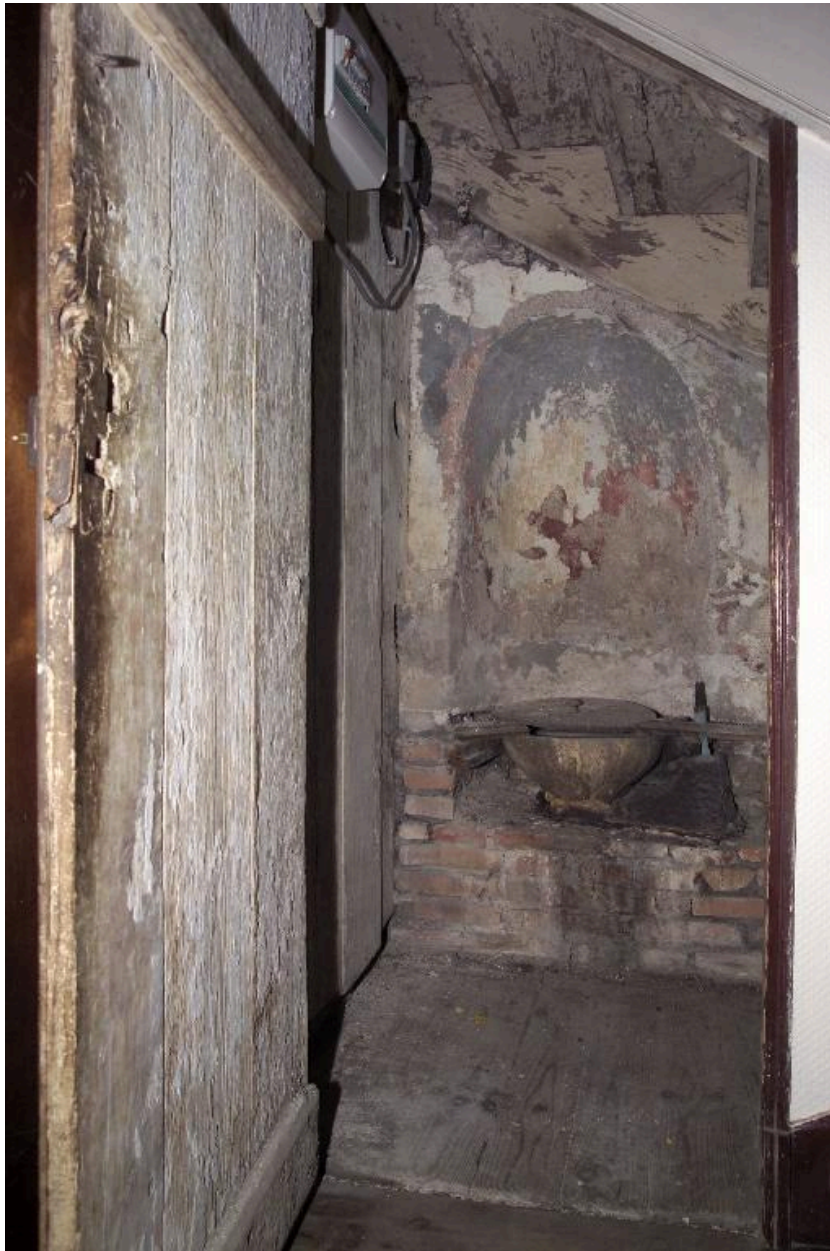
Les latrines, sous l'escalier.
