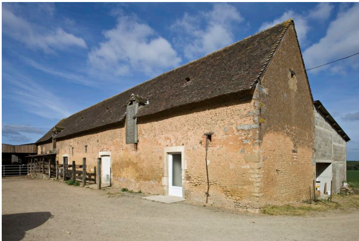
Etables H, vues depuis le nord-est.
