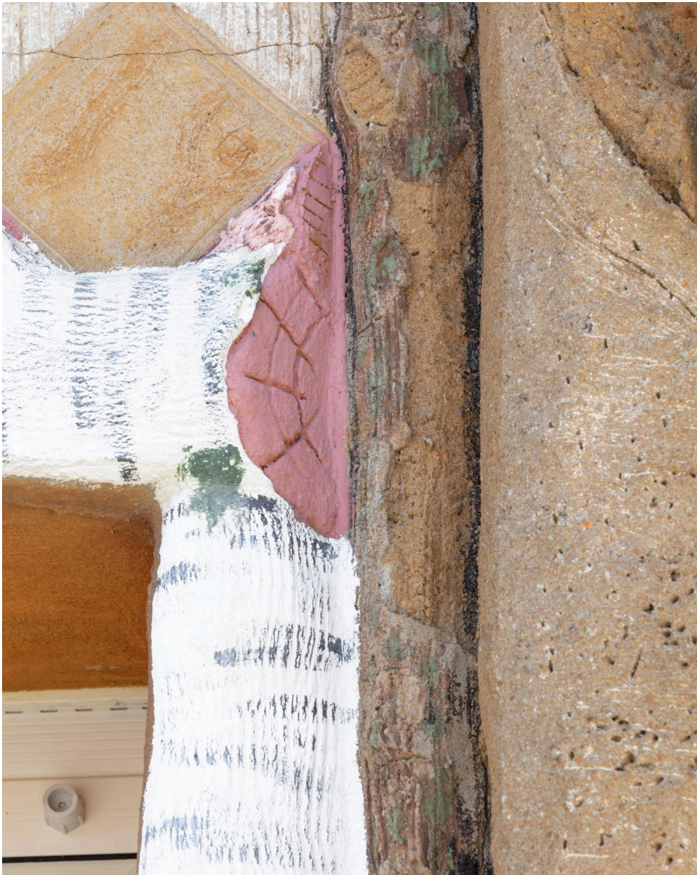
Détail d'un motif de tronc écoté encadrement de fenêtre en rez-de-chaussée de la façade sud.
