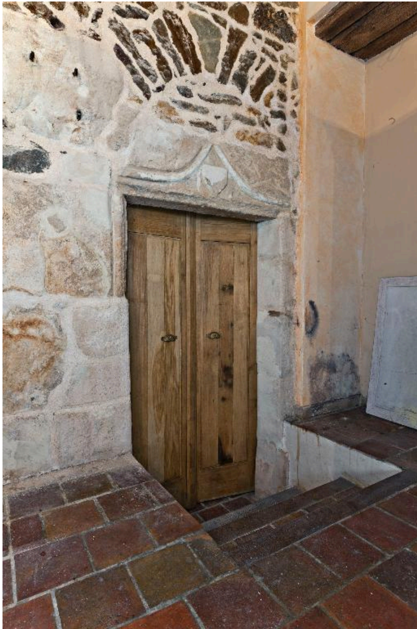
Porte intérieure donnant accès au sous-sol.
