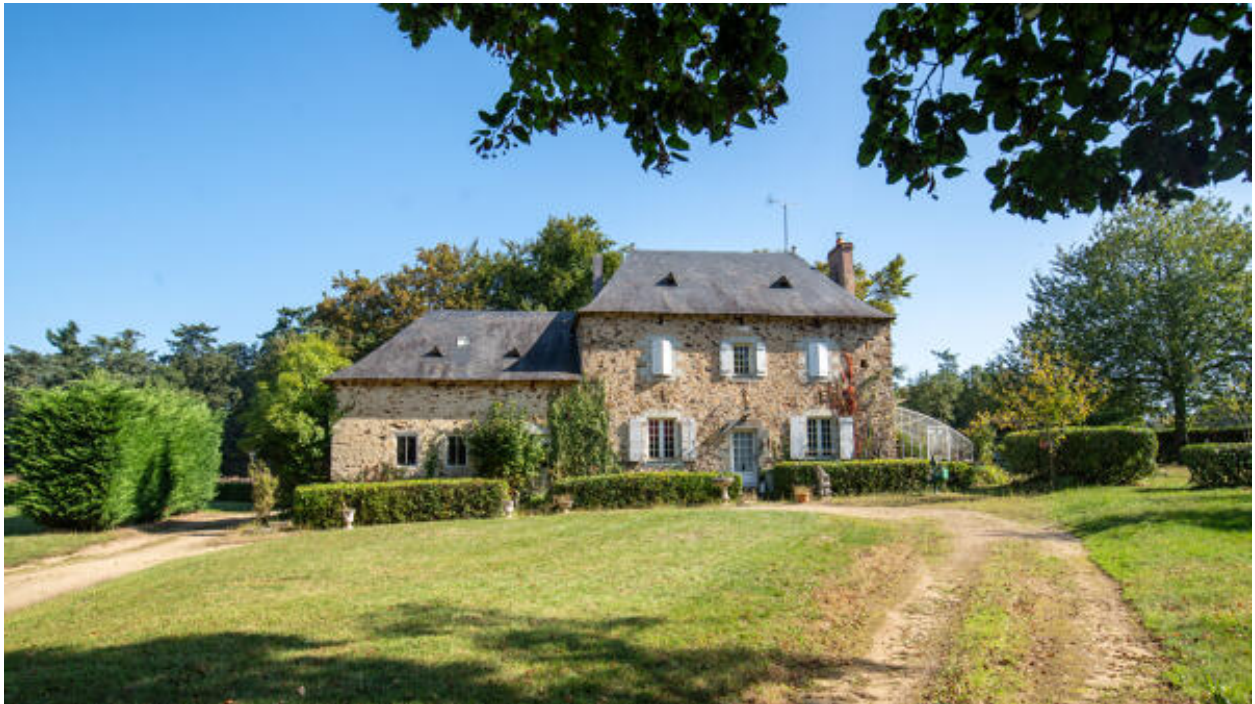
Le logis du gardien, anciennement logis du métayer puis du jardinier, et la serre.
