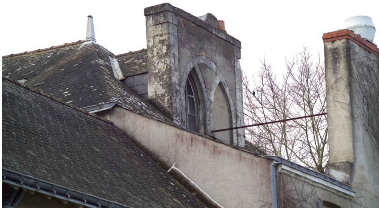
Partie principale, détail d'une souche de cheminée.
