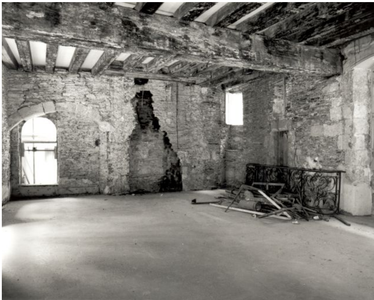
Corps postérieur, pièce du 1er étage : mur postérieur et latéral droit. Etat pendant les travaux de restauration.
