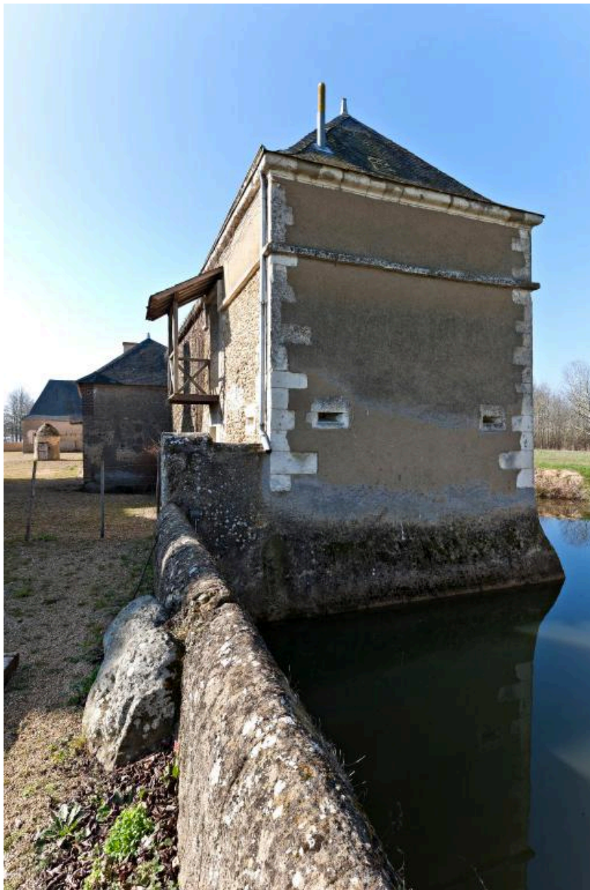
Vue des communs depuis le nord.
