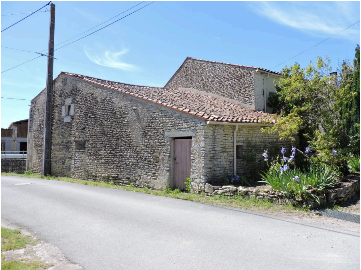
La dépendance vue depuis le nord-est.
