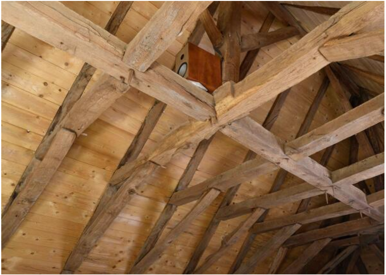
Détail de la charpente du logis.
