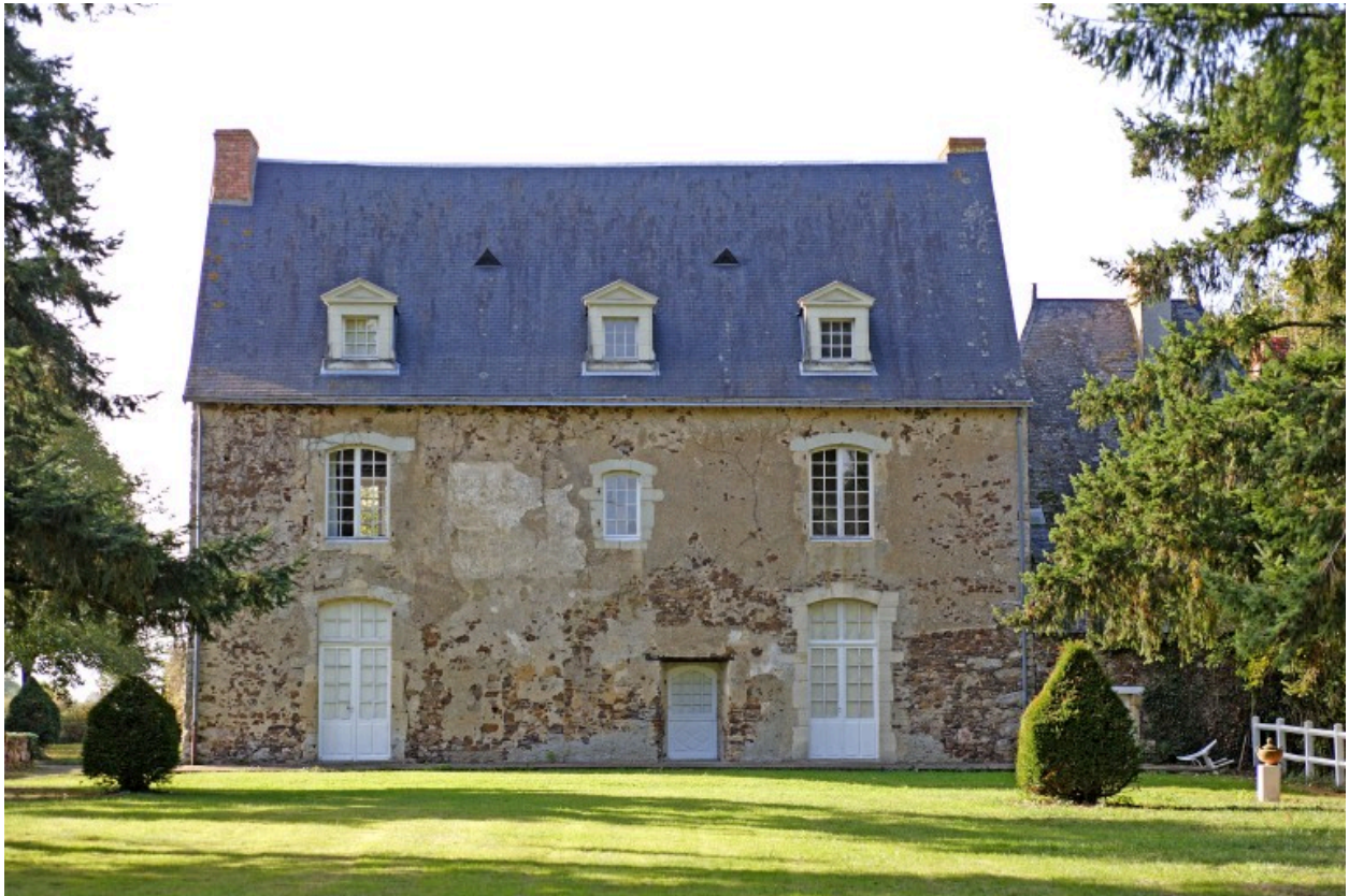
La façade postérieure vue depuis l'est.
