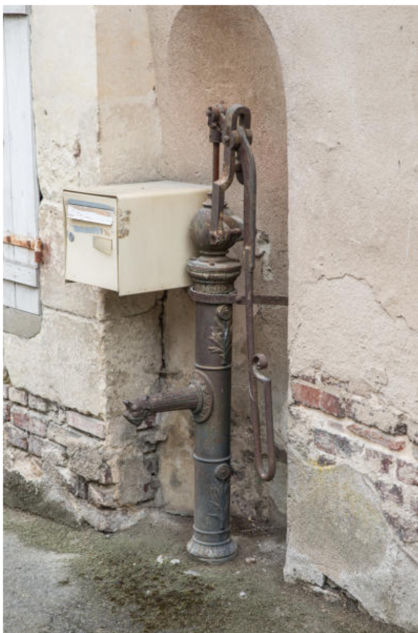
Pompe à eau à bras, rue A. de Tocqueville.
