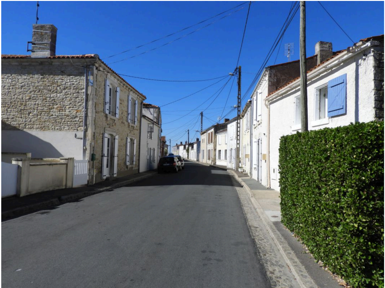
Fronts bâtis de part et d'autre de la rue des Faïenciers.
