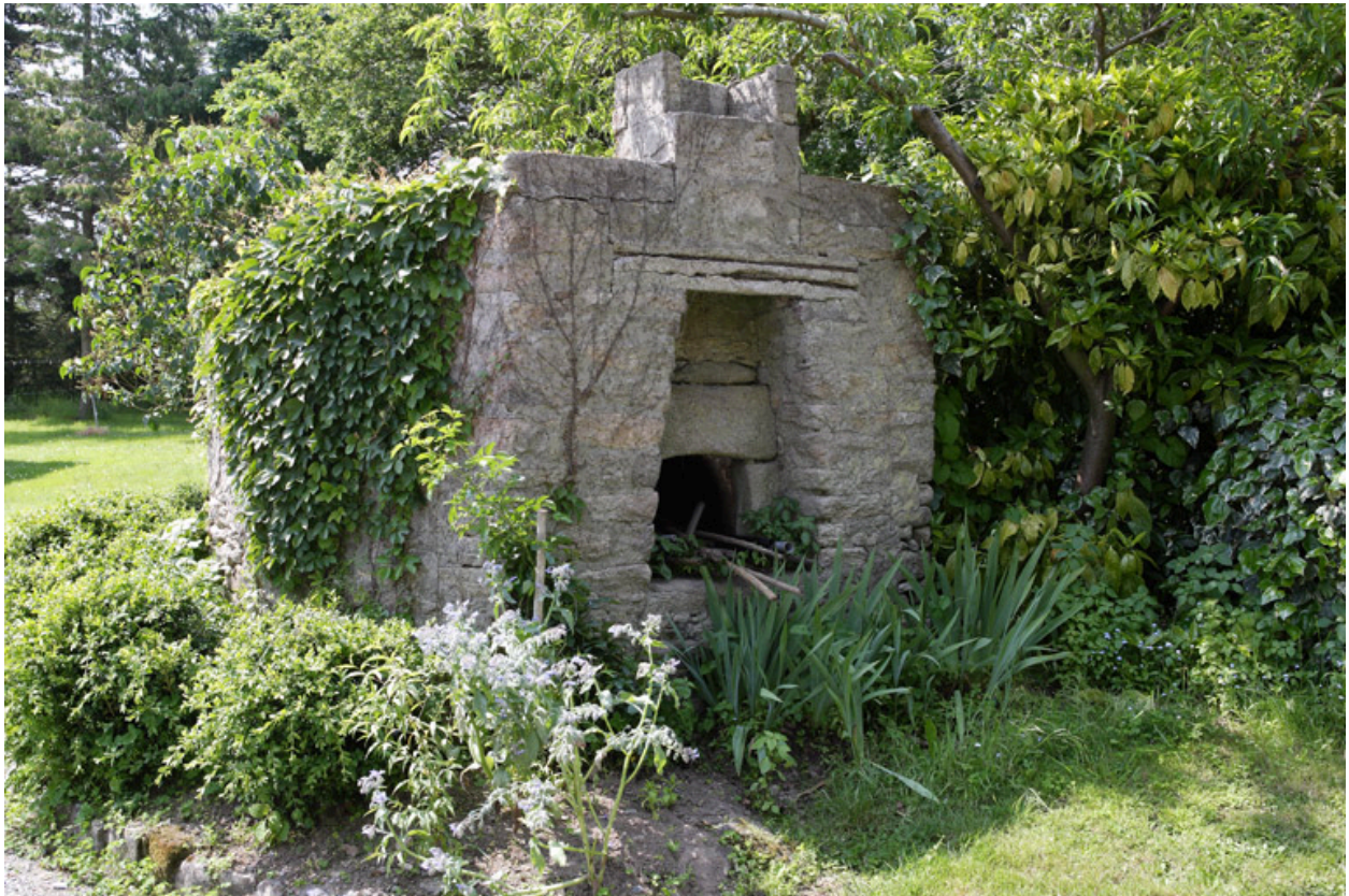
Vue du four à pain.
