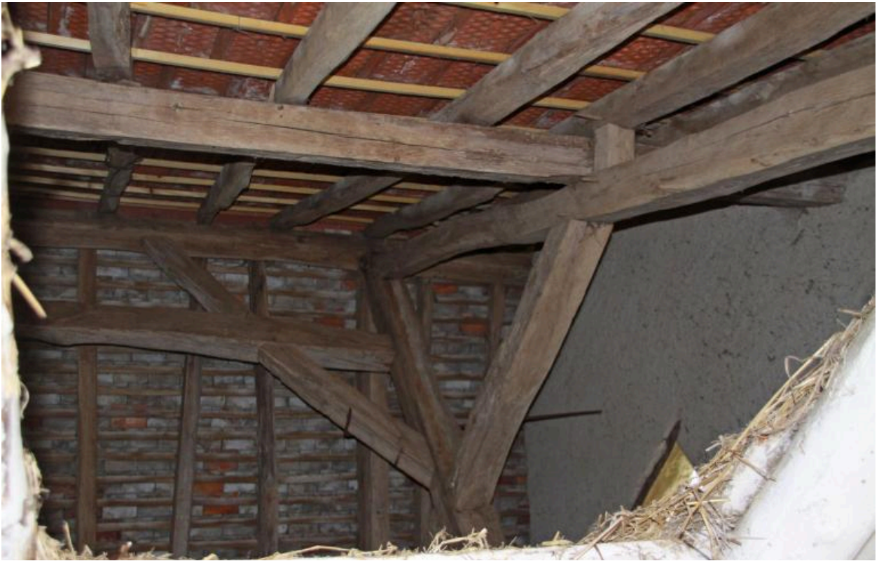
Comble : charpente au-dessus de la dépendance.
