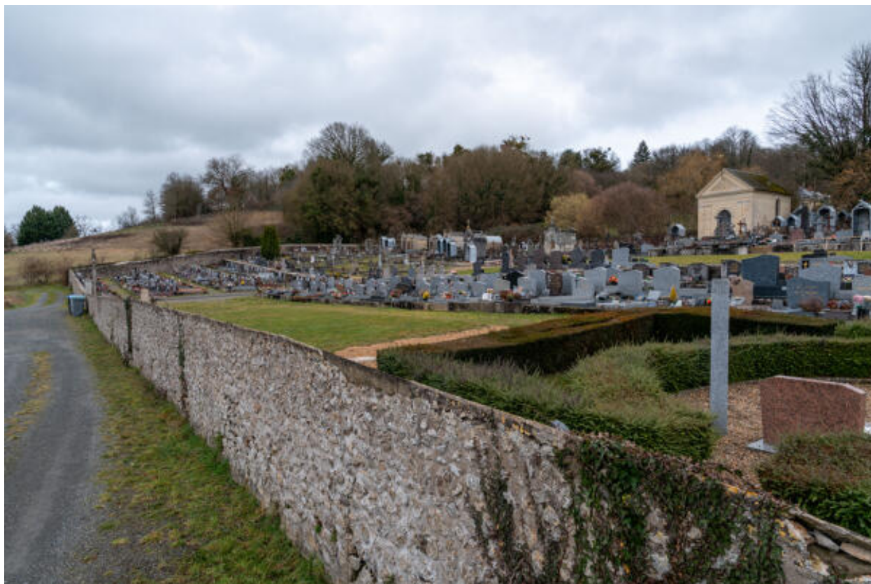
Vue d'ensemble avec le mur de clôture depuis le sud-ouest.
