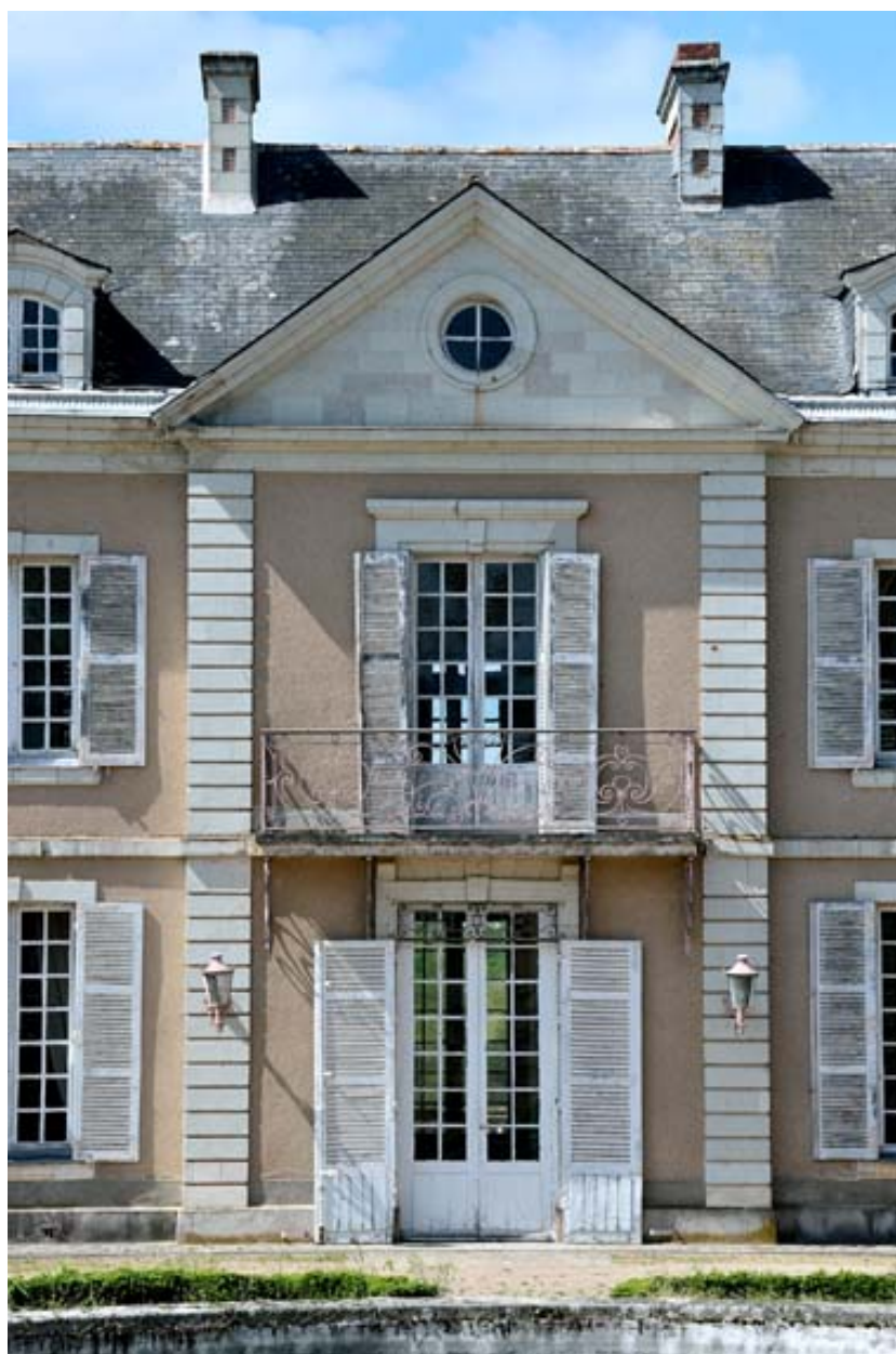
Mantelon. Château. Façade est. Détail de la travée centrale.
