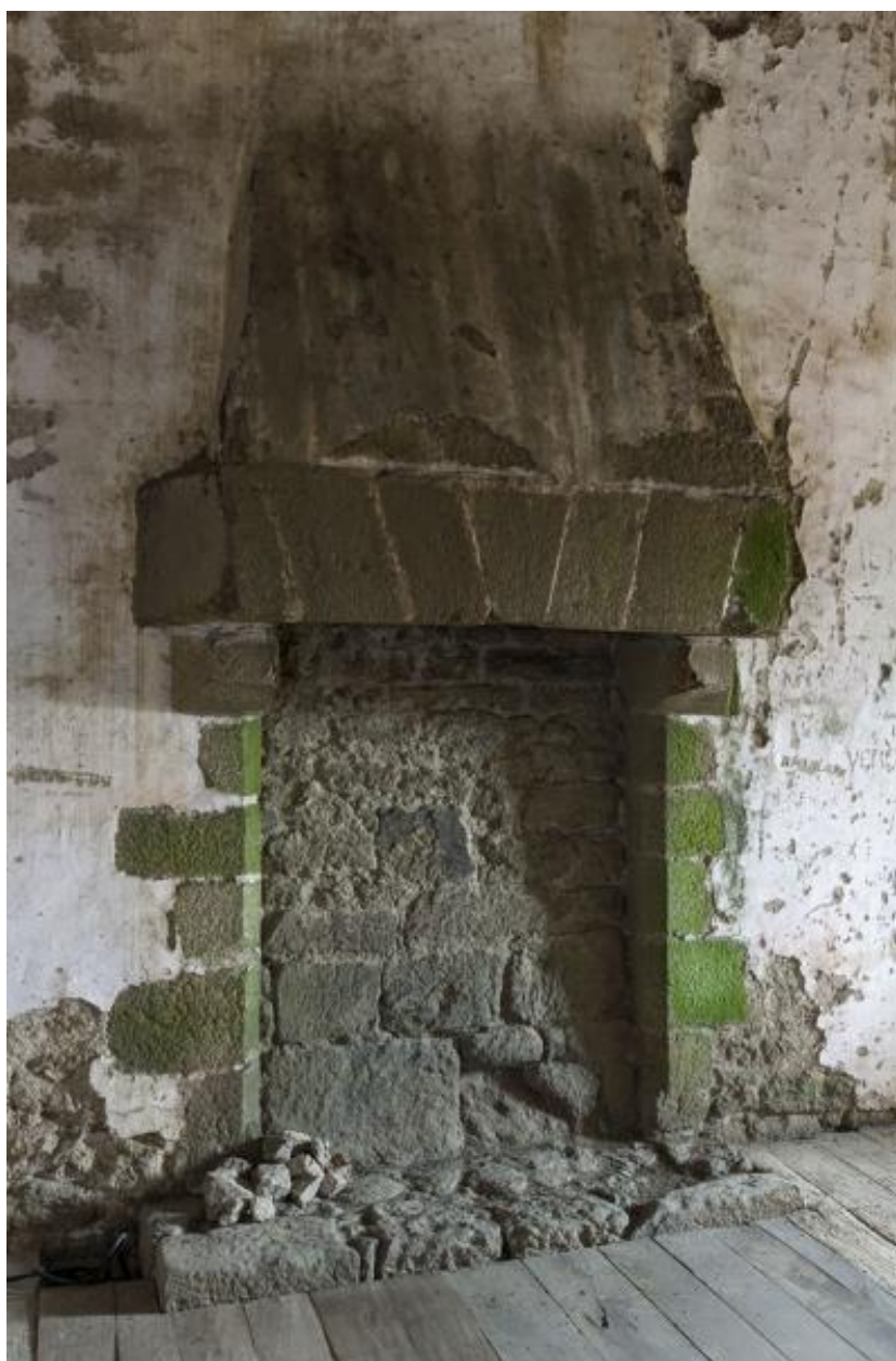
Cheminée du 2e niveau de la tour Lavoisier.
