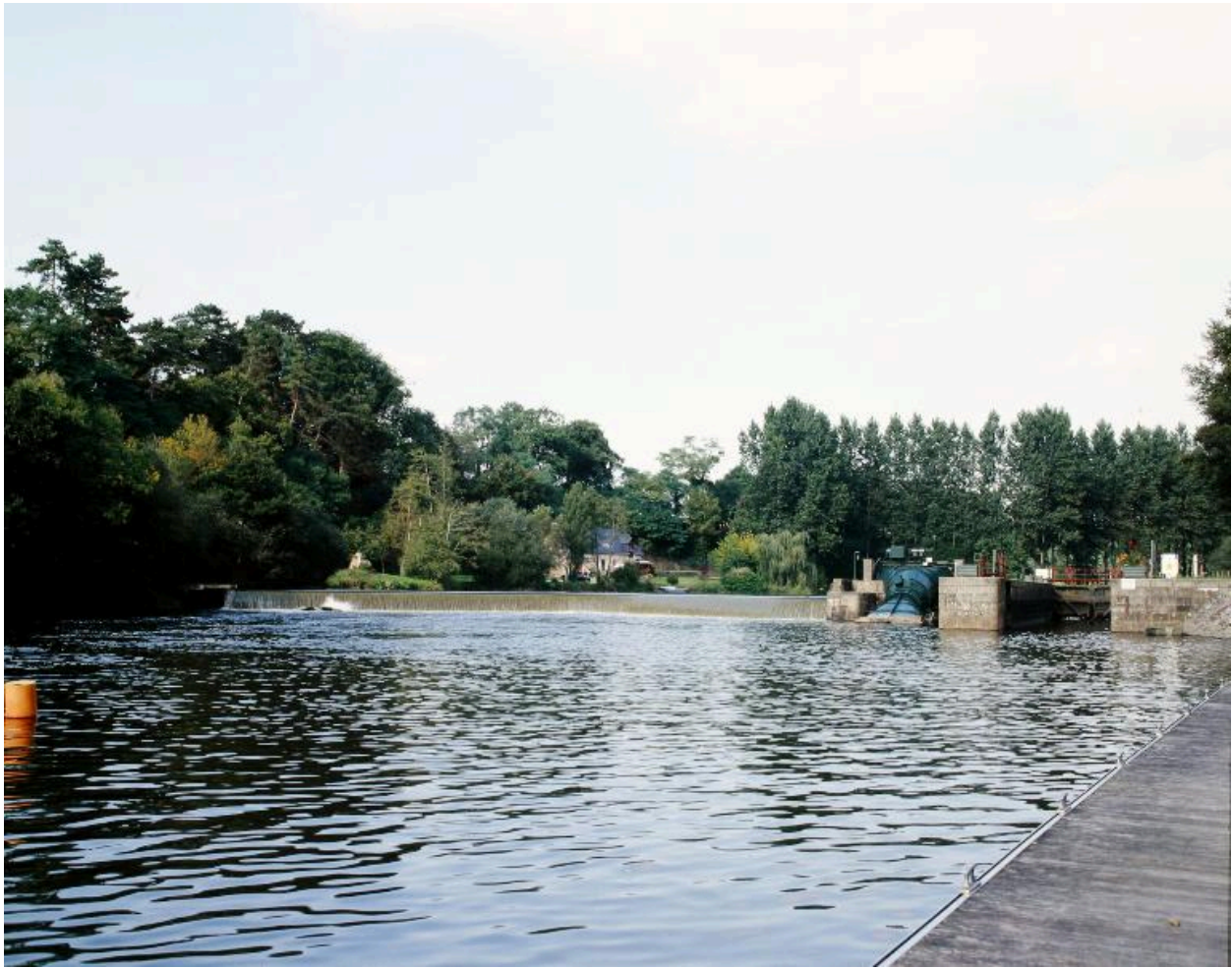
Vue d'ensemble du site d'écluse depuis le ponton situé en aval : barrage, centrale hydroélectrique, écluse.
