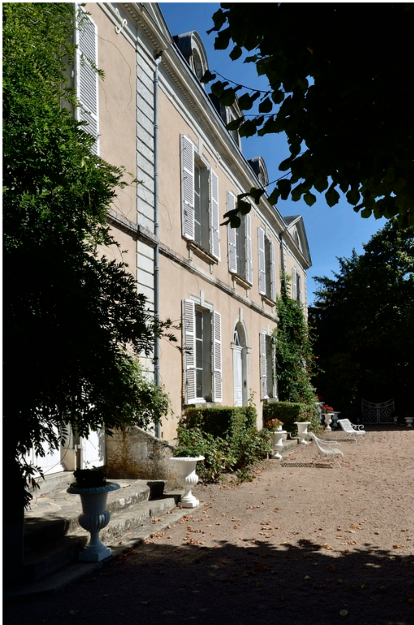
Vue de la façade depuis le sud-ouest.
