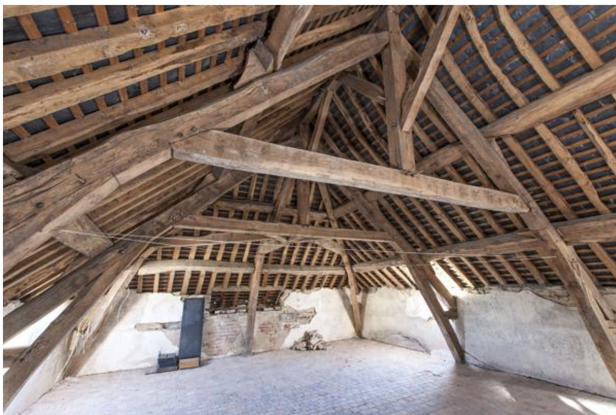
Charpente du château de la Drouardière.
