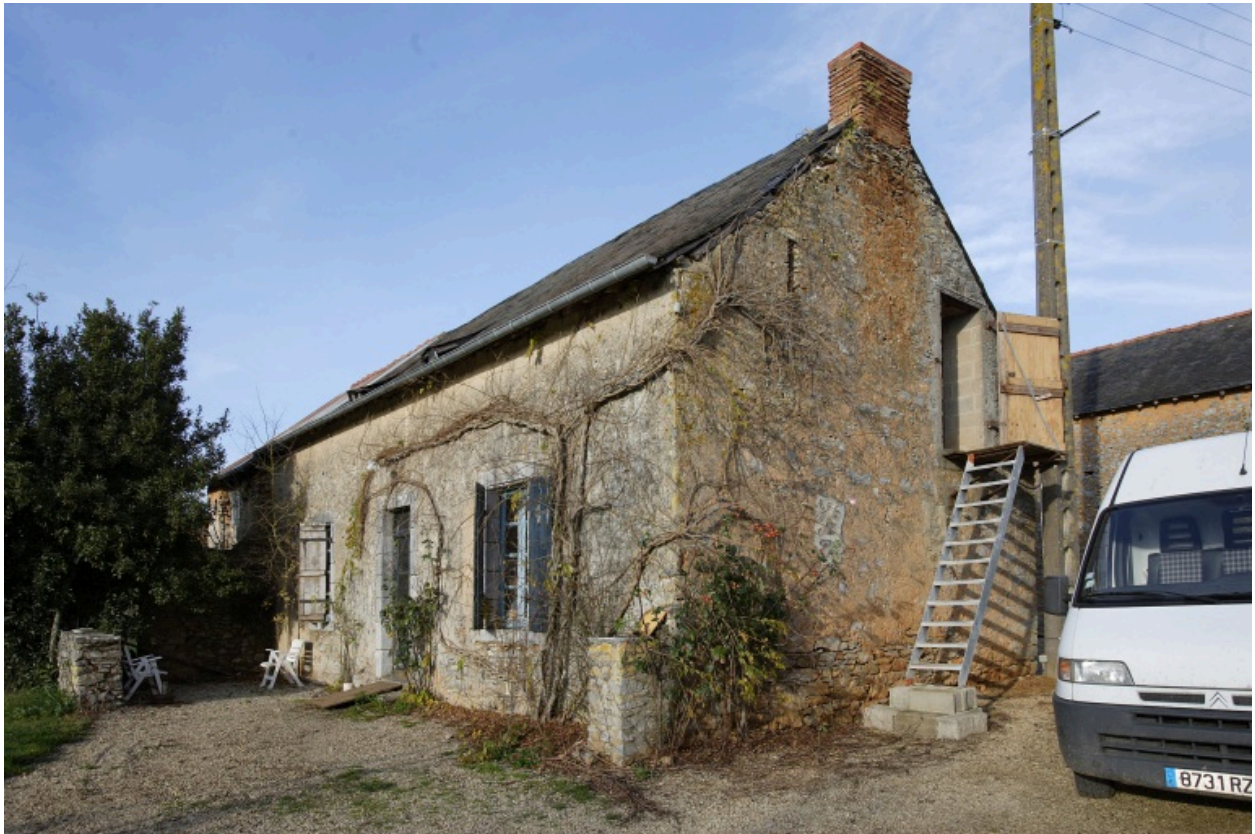
Le logis vu depuis le sud.
