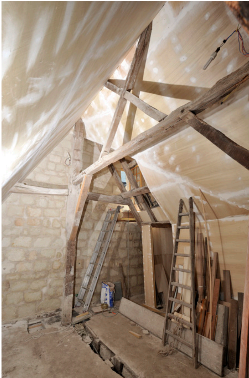
Charpente (vue vers le sud).
