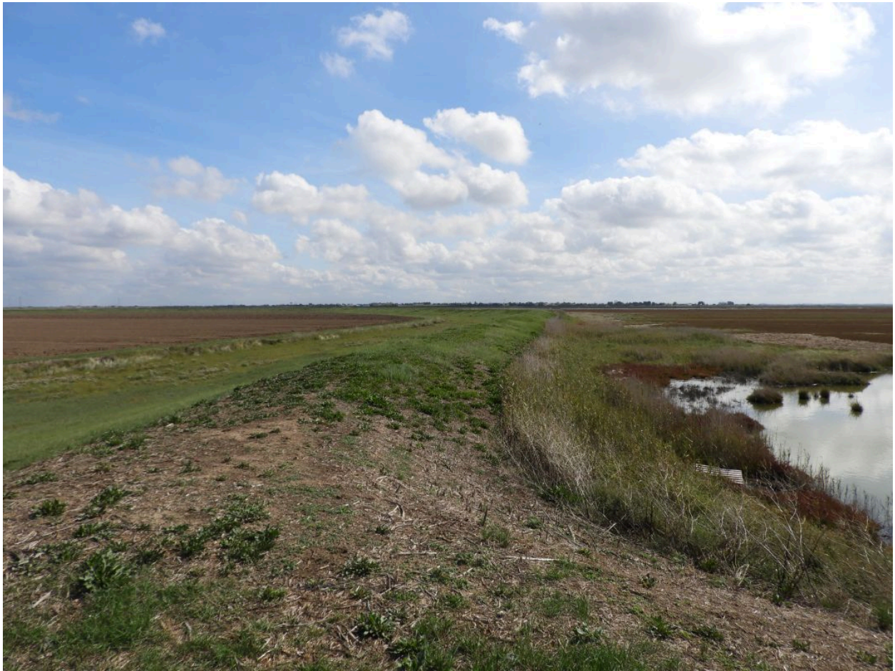
La partie sud de la digue de la Bosse, à sa jonction avec la digue d'En bas, vue en direction de l'est.
