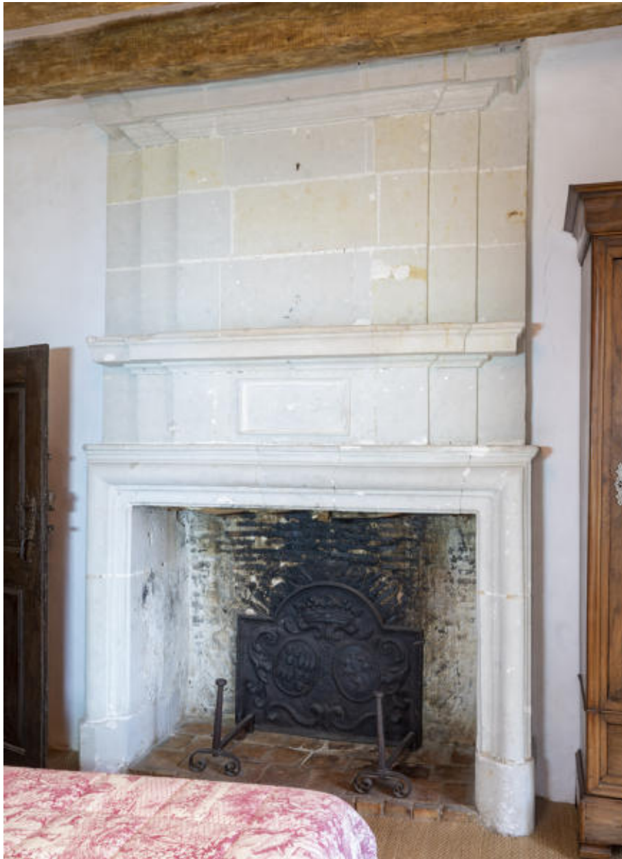
Une cheminée de l'étage.
