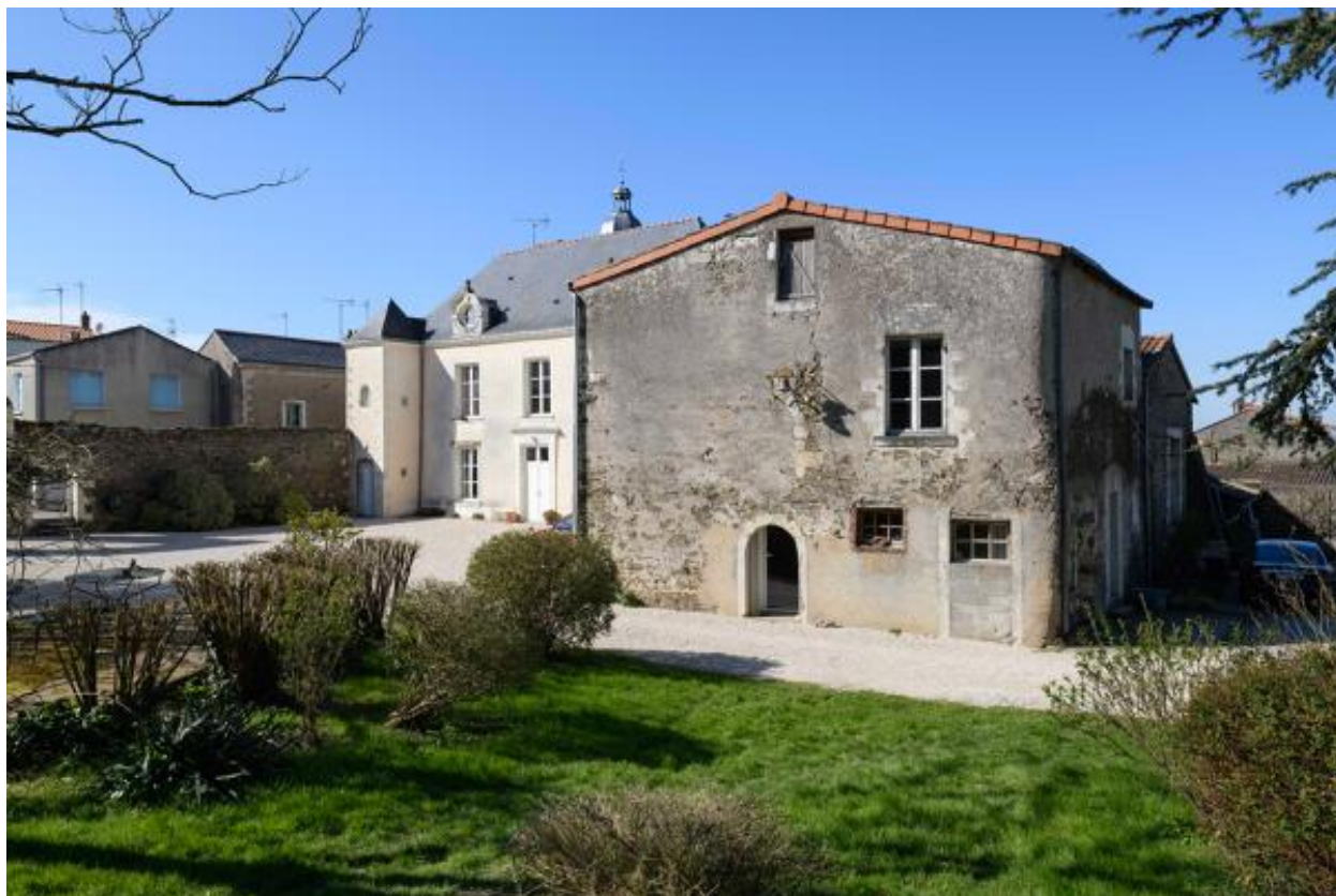
Vue du bâtiment sud.
