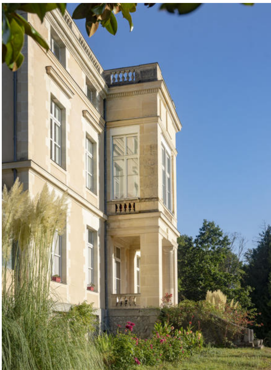
L'avant-corps de la façade antérieure.
