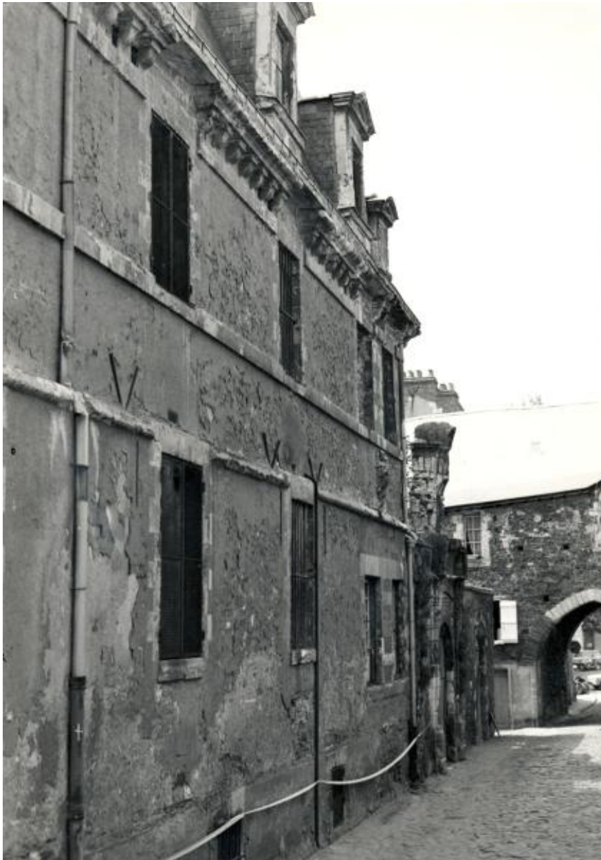
Bâtiment conventuel, façade rue de la Censerie, point de vue opposé.
