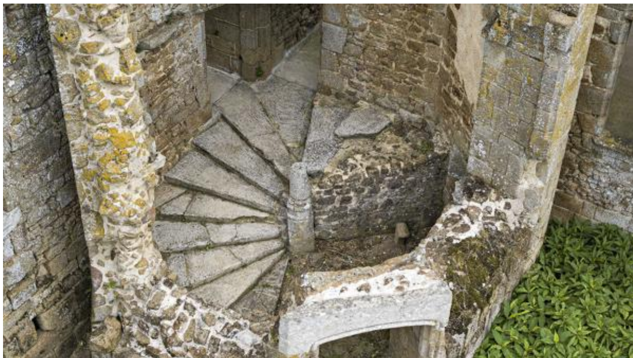
Escalier du corps de logis nord-ouest.
