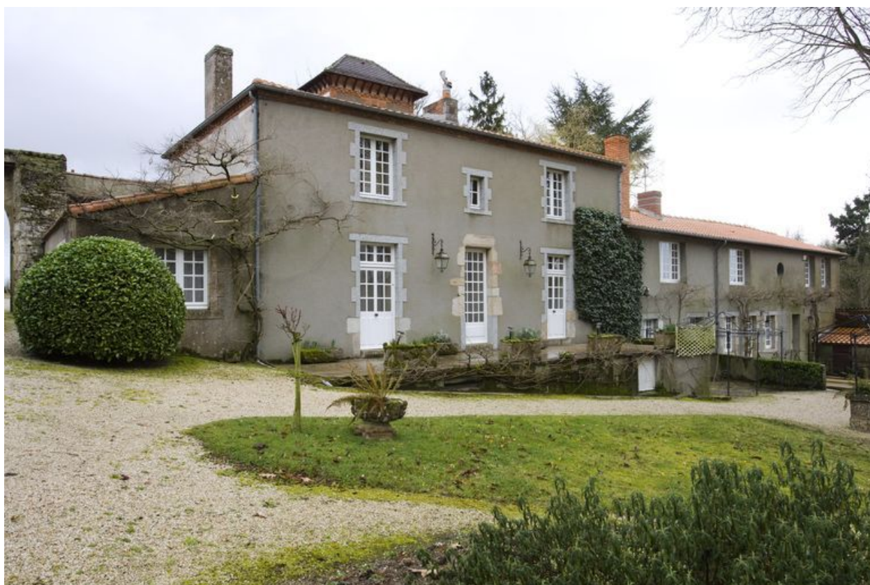
La maison de maître : façade ouest.
