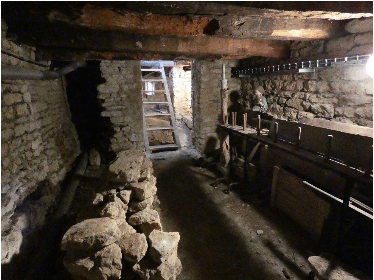
Le soubassement sous la sacristie nord-est.
