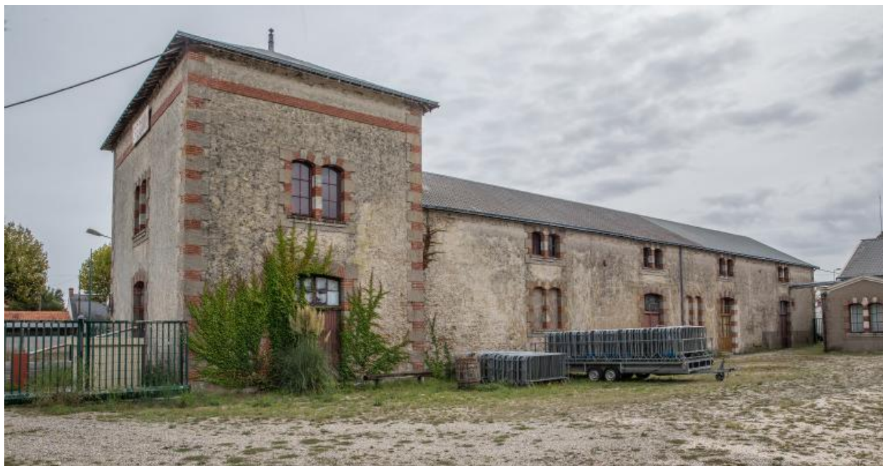
Élévation ouest, chai nord, 2018.
