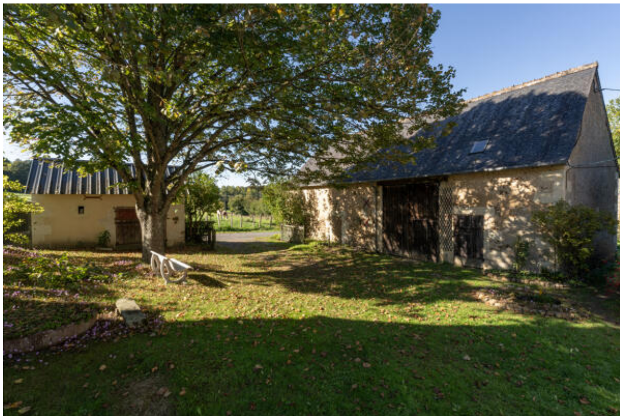
Ferme ouest : vue sur la cour avec grange-étable et étable.
