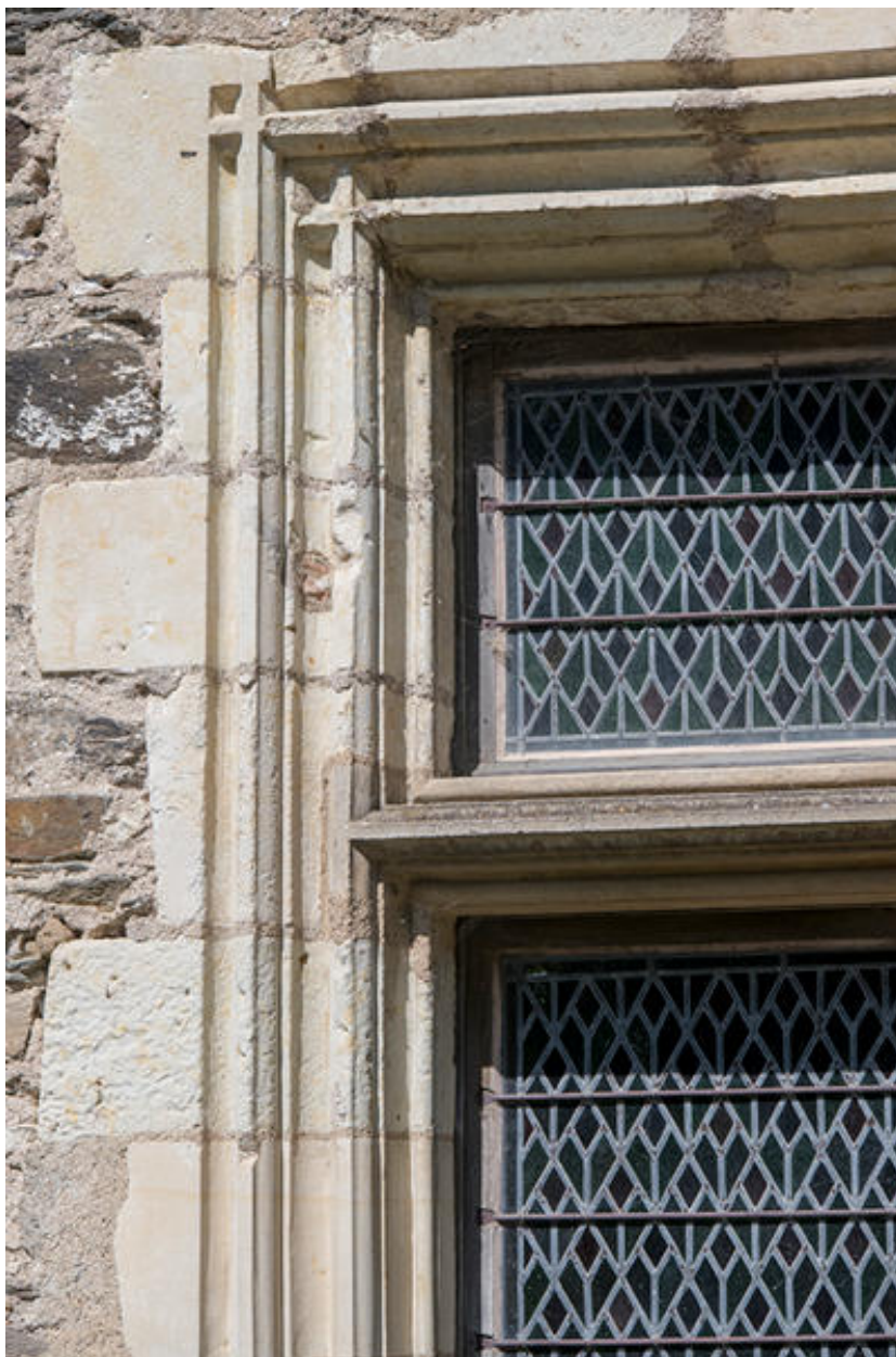
Détail de la moulure en "baguettes croisées" de la croisée du logement du prêtre.
