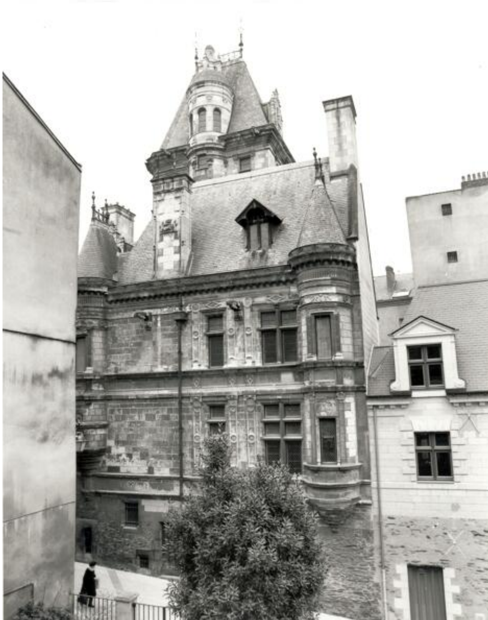
Corps de logis droit : façade sur la rue de l'Espine.
