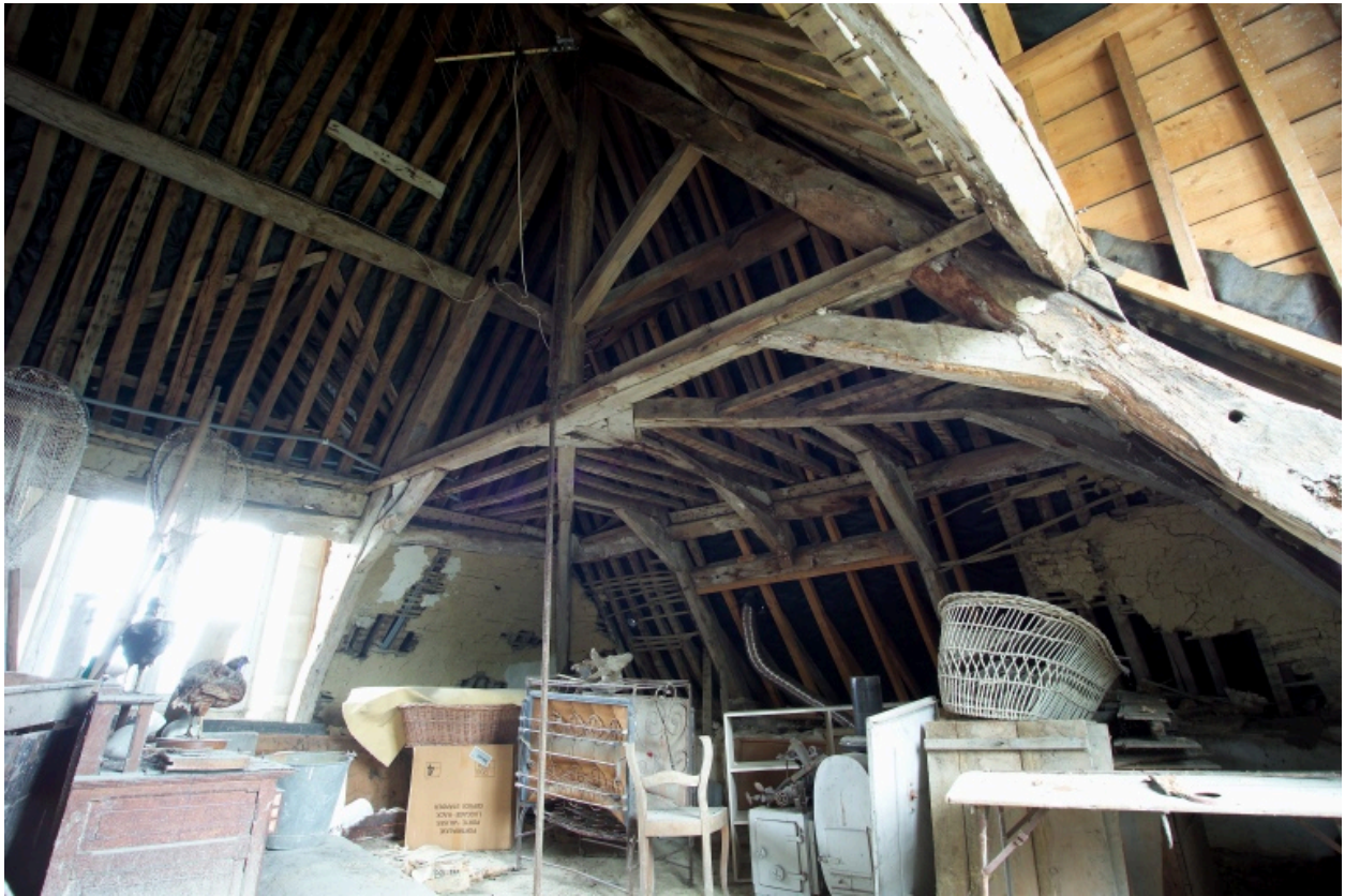
Vue de la croupe de charpente de l'aile sud.
