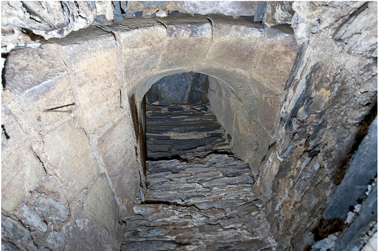
Corps de bâtiment du petit séminaire, sous-sol : cave 1, angle postérieur gauche, puits, vue en contre-plongée avec l'arc d'accès au premier plan.
