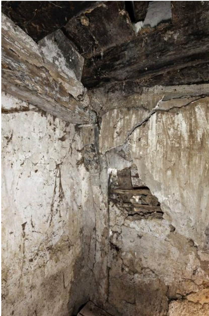
Poteau nord-ouest et poutre de rive.
