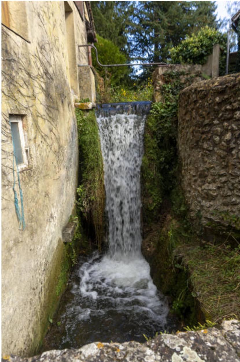
Vue de la chute d'eau qui alimentait la roue située en pignon.
