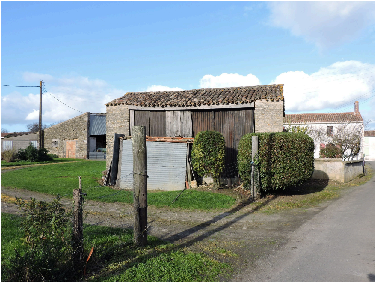
Hangar au sud de la cour, vu depuis le sud.
